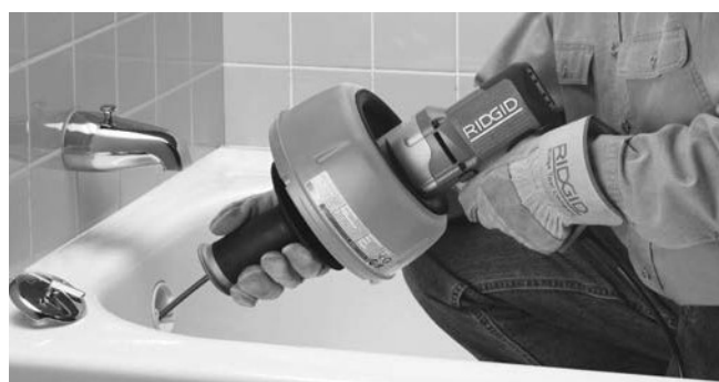
Рис. 9 – Протолкните трос дальше в канализационную трубу
